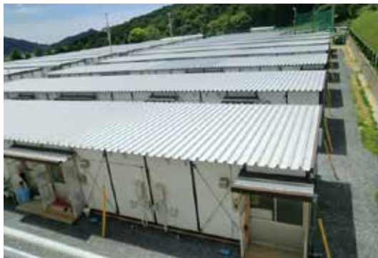
大船渡中学校校庭の仮設住宅
