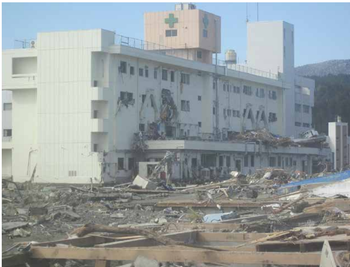
津波で被災した公立志津川病院。5階建てであるが、4階まで浸水した。正面玄関にはなおも瓦礫が残り、被害の大きさを物語っている。
